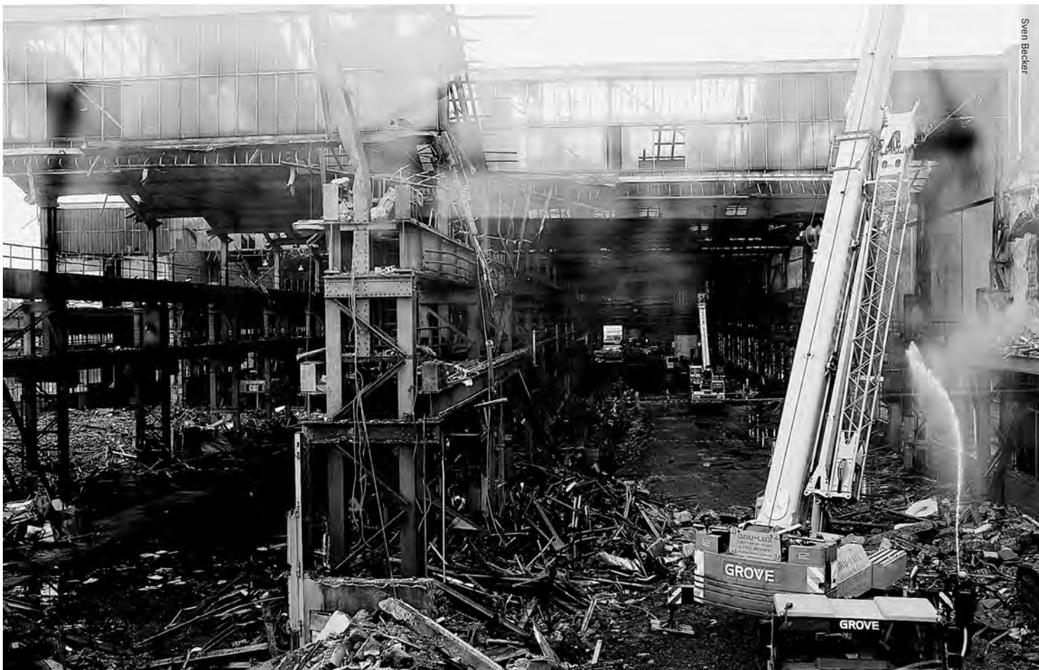
Été 2017 : Démolition du centre de remisage et de maintenance à la Gare centrale
