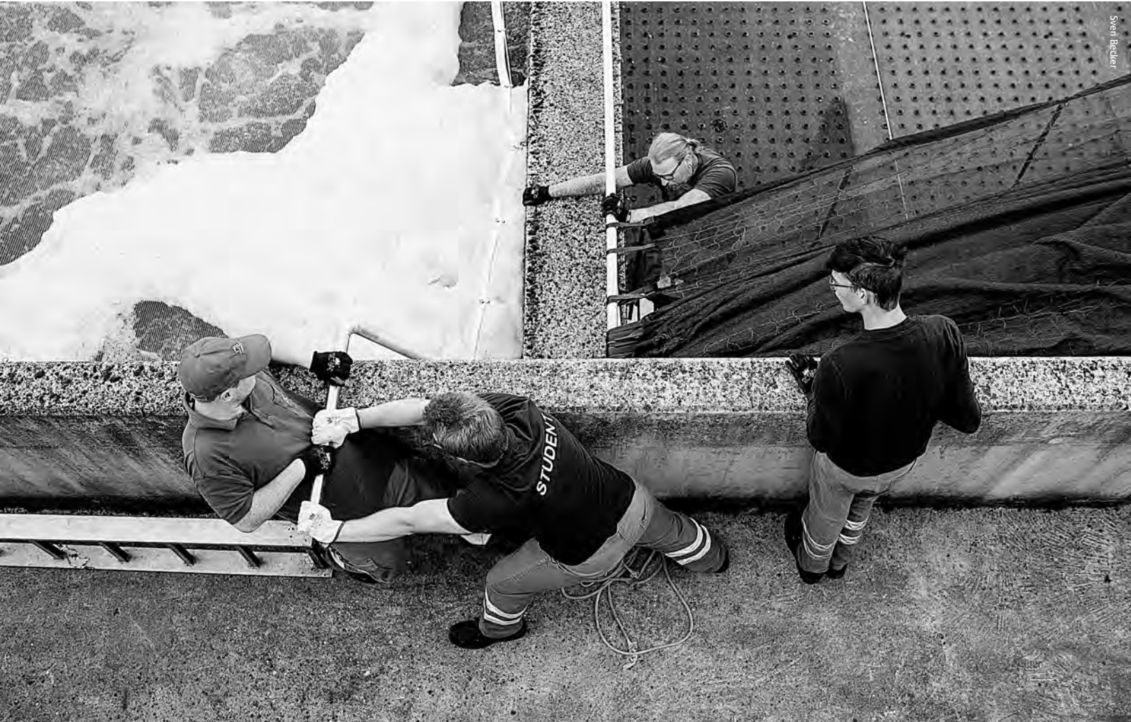
Station d’épuration à Beggen. « Dans une situation d’urgence, je crains qu’on ne dise : Les gens pourront toujours acheter du Vittel, mais les serveurs de Google, eux, vont clamser sans eau de refroidissement », dit Blanche Weber
