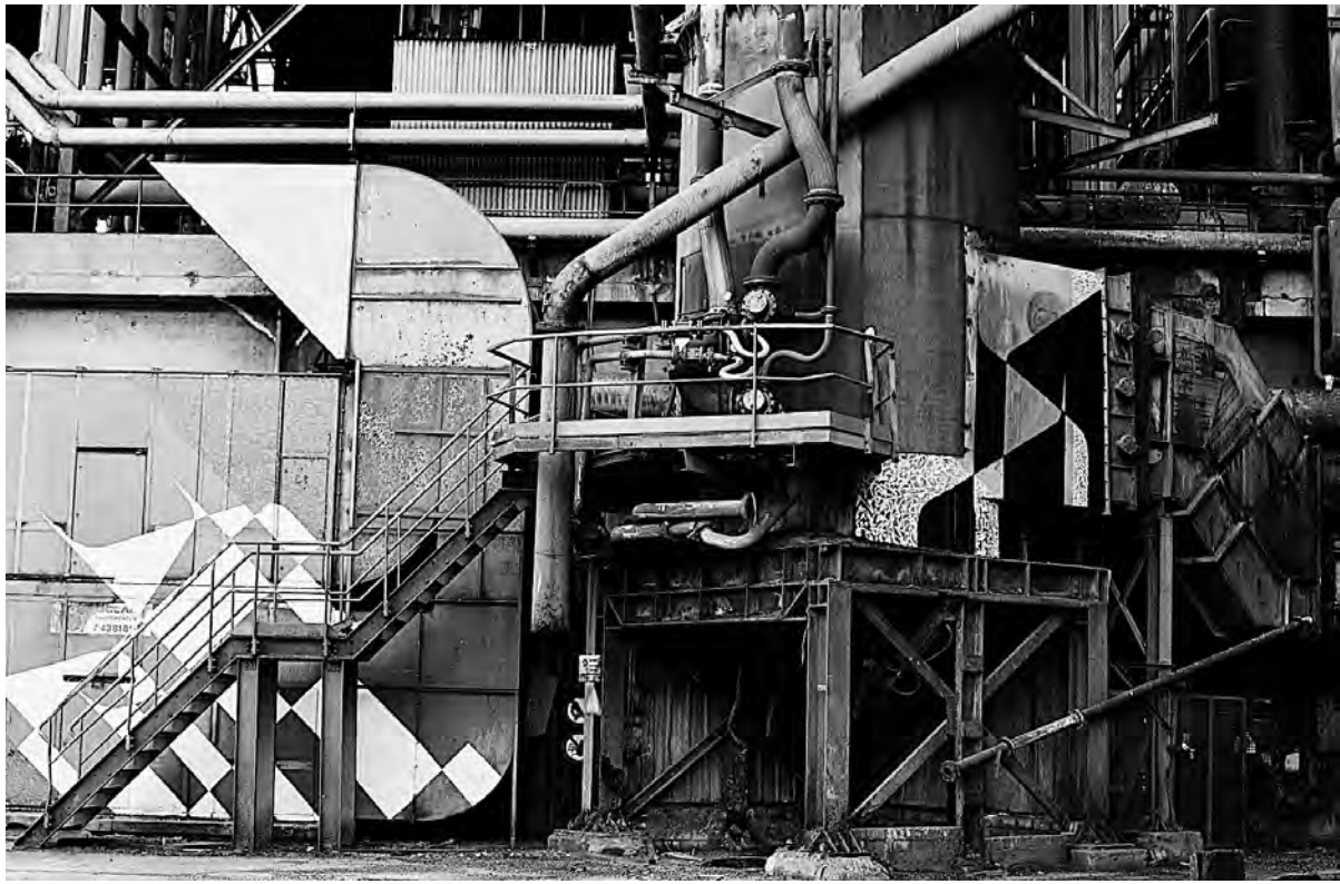
Le poste de gardien de ce portail semble avoir été abandonné avant-hier ; les artistes graffiti Spike & Stick se sont approprié le site ; la salle des pompes est en bon état la tour d'eau est protégée ; décor de cinéma
