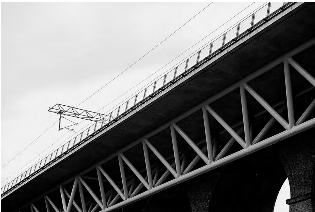
Zwei Generationen Viadukt: links der neue Anbau der Biisserbréck auf seiner Stahlkonstruktion, rechts das 150 Jahre alte, aber gründlich verstärkte Viadukt auf dem 130 Meter hohen Hang
