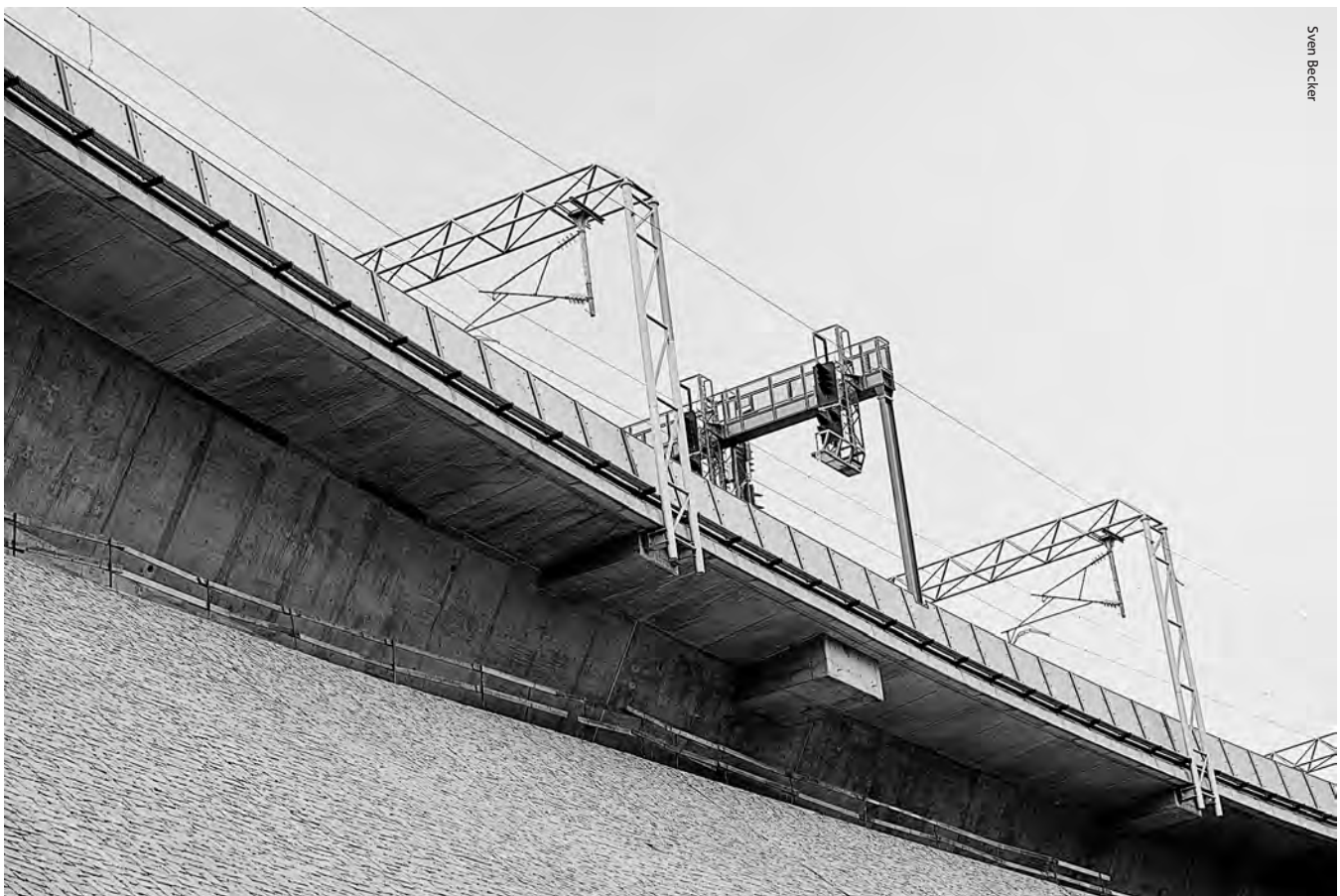
Zwei Generationen Viadukt: links der neue Anbau der Biisserbréck auf seiner Stahlkonstruktion, rechts das 150 Jahre alte, aber gründlich verstärkte Viadukt auf dem 130 Meter hohen Hang
