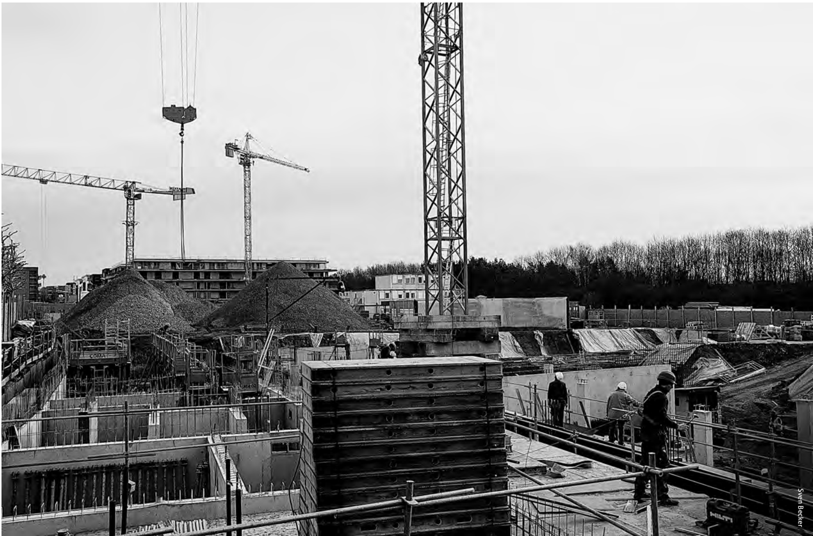
Wohnungsbau-Großbaustelle der SNHBM auf dem Kirchberg
