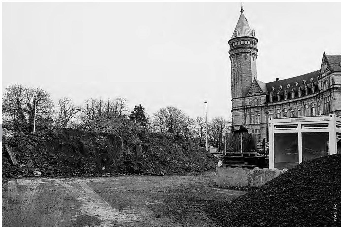
La petite capitale aux airs de carte postale est défigurée. Des trous partout, des chantiers, des grues, du béton...
