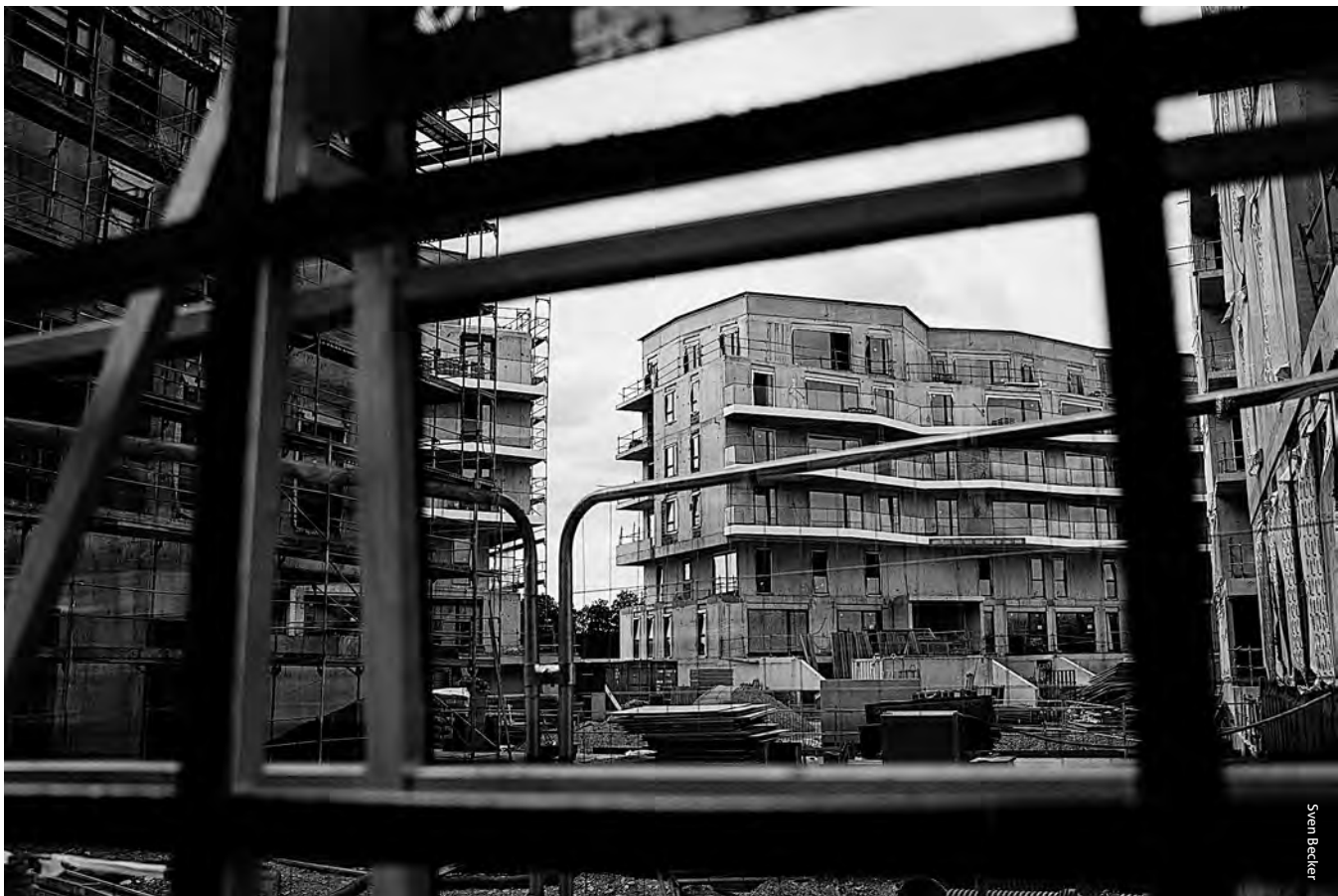
Baustelle der SNHBM für das Wohnviertel Réimerwee auf dem Kirchberg
