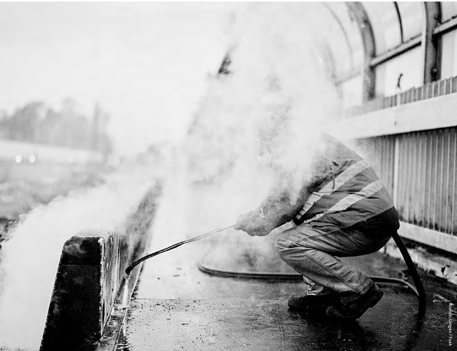
Un ouvrier au travail sur le pont, en hiver 2016
