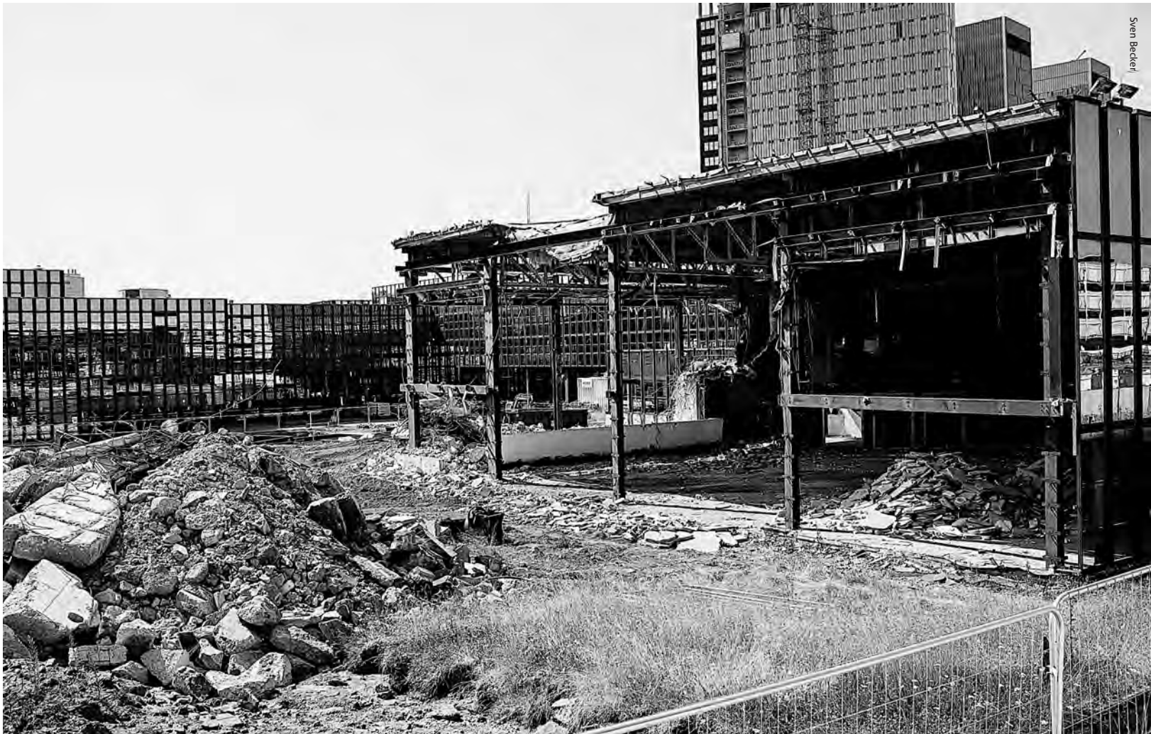
Les bâtiment Jean Monnet, qui hébergeait des bureaux de la Commission européenne, en train d’être démolì sur le Kirchberg, boulevard Konrad Adenauer
