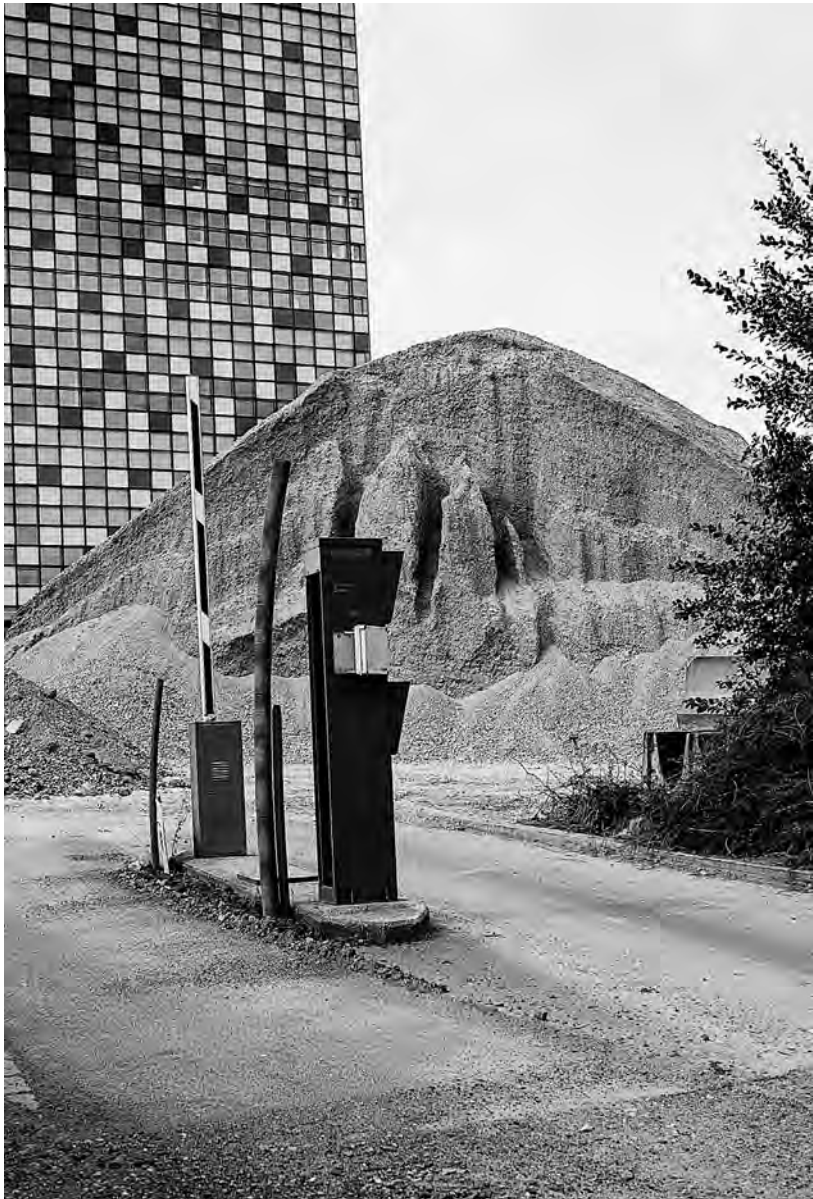
Le chantier devant RTL City, où l'ancien bâtiment a déjà été démol
