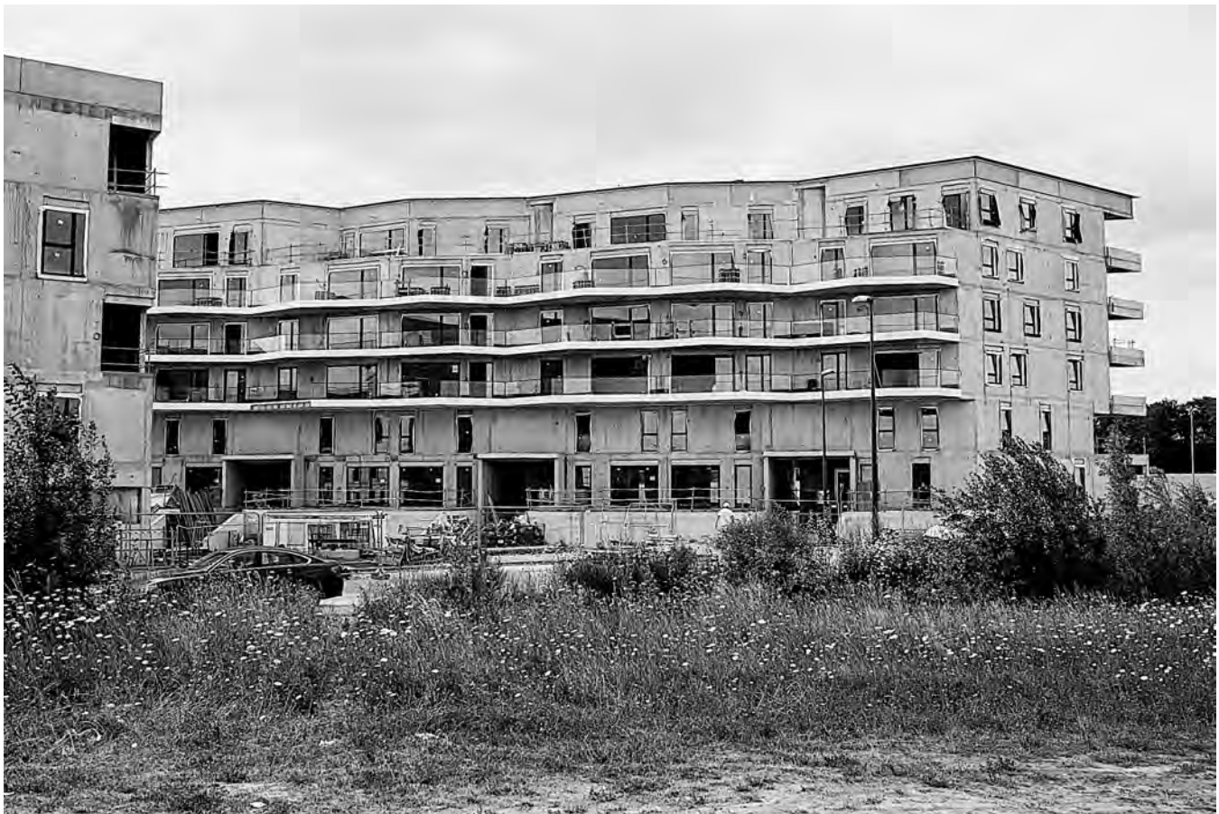
Le bâtiment de luxe Infinity en construction à l'entrée du quartier (en haut à gauche) ; difficiles à trouver : de banals piétons ; le lotissement Reimerwee de la SNHBM, en construction en face de RTL
