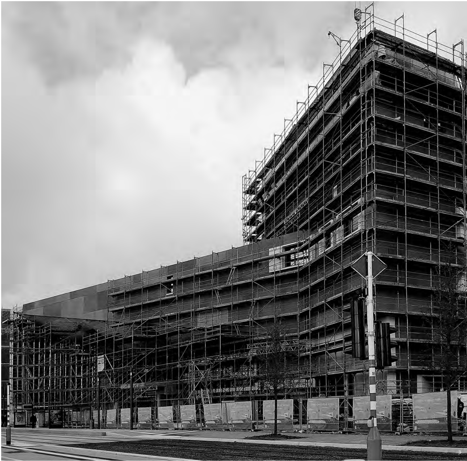
Die Baustelle der neuen Nationalbibliothek auf dem Kirchberg. Warum ist der Neubau nur auf 30 Jahre ausgelegt?
