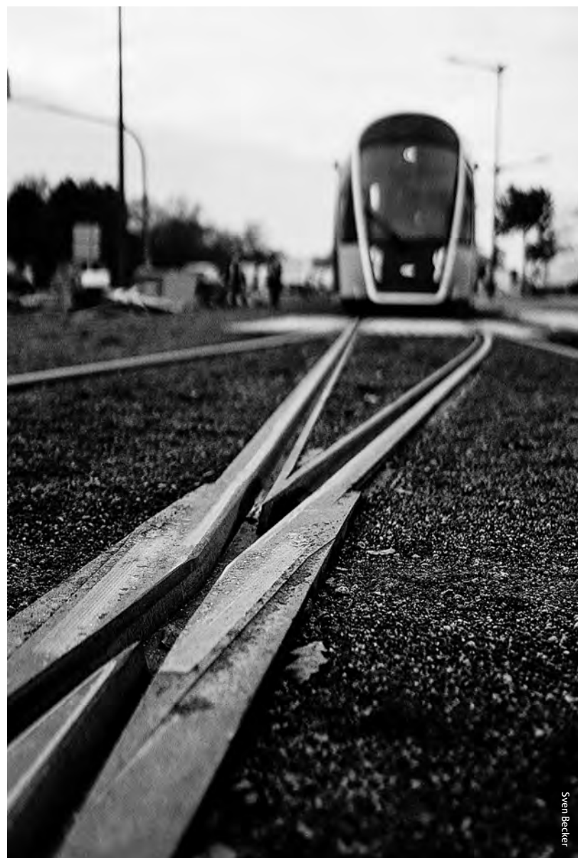
Straßenbahngleise auf dem Kirchberg
