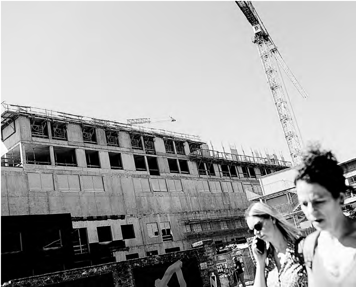
Großbaustelle CHL: 2029 soll das neue Bâtiment Centre bezugsfertig sein
