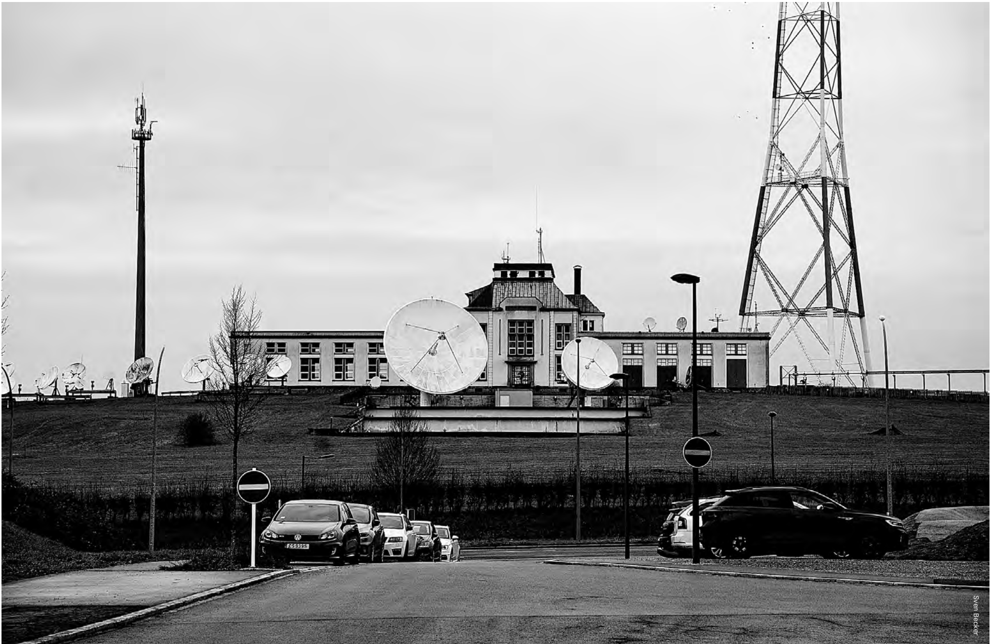
Das Hauptgebäude aus den frühen 1930-er Jahren orientiert sich an europäischen
