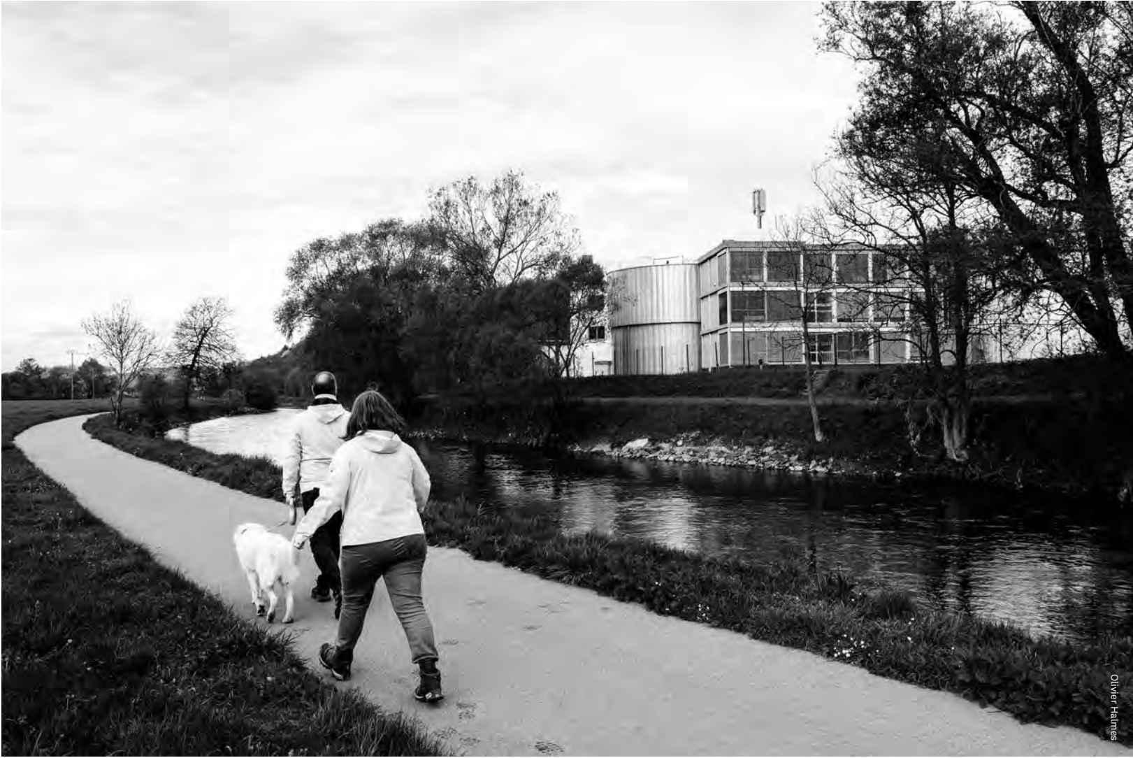
Achevée en 2018, la modernisation de la station d’épuration de Bleesbruck a permis au pays de se mettre en conformité au niveau européen. Pour un temps
