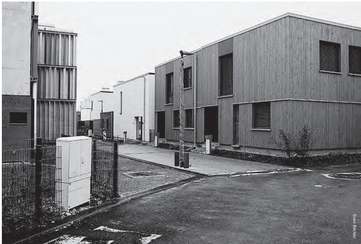
Dans la nouvelle cité SNHBM à Elmen
