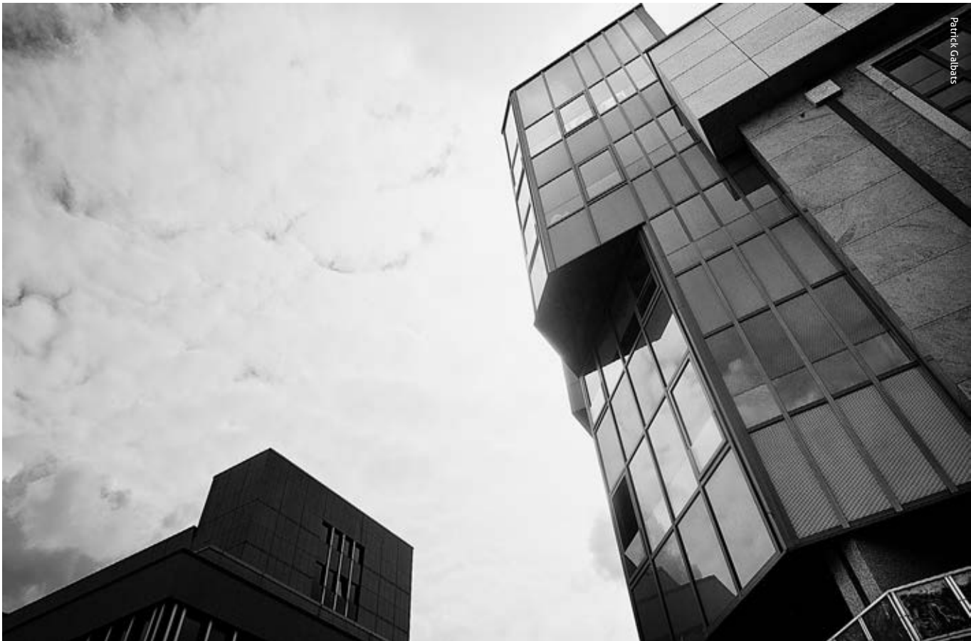
Au croisement de la rue du Fort Wedell et de la rue du Commerce : bâtiment de l'administration fiscale hébergeant le bureau d'imposition Sociétés 6
