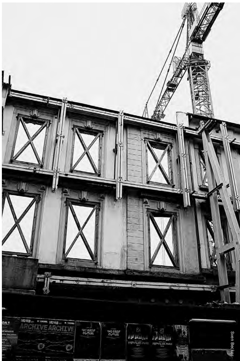
Abriss in der Avenue de la Gare
