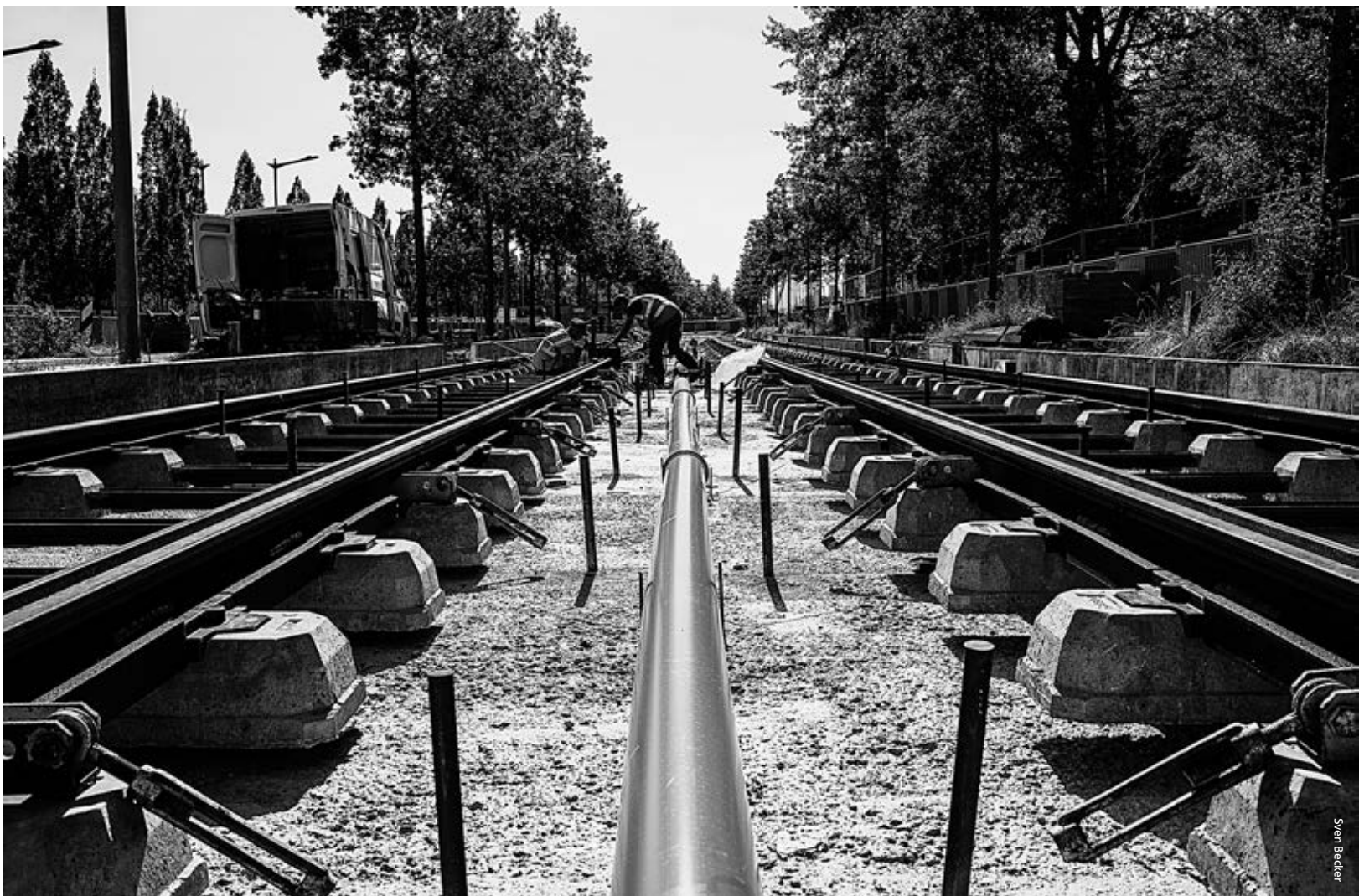
Tram-Baustelle auf dem Kirchberg
