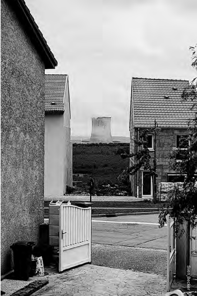
Boom immobilier, à l'ombre de la centrale de Cattenom
