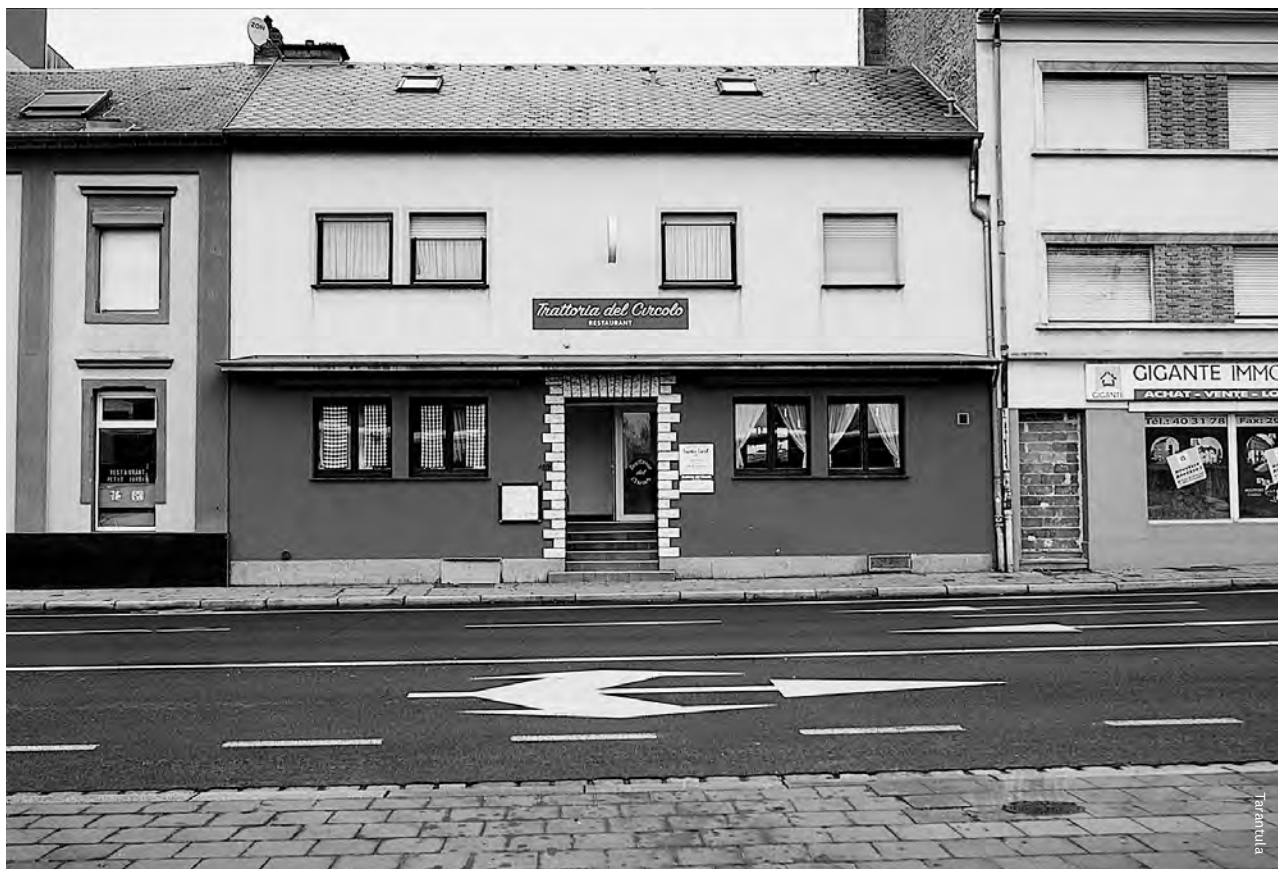
La façade du 107 route d'Esch avant démolition
