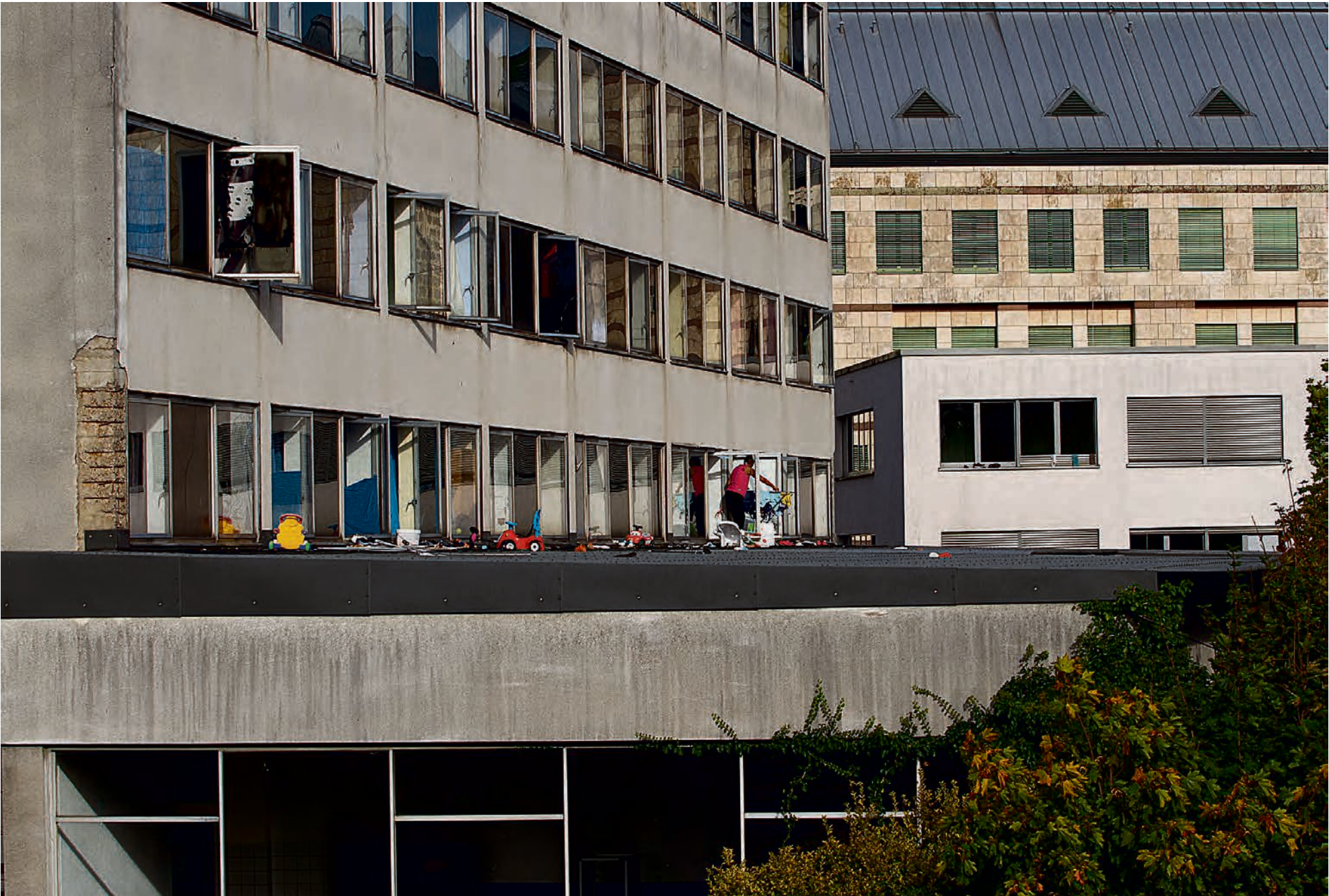
Le toit du foyer Don Bosco au Limpertsberg (octobre 2023)
