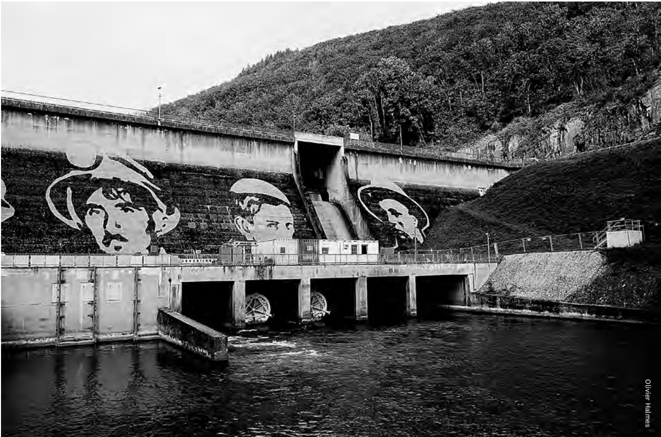
Mit dem Viandener Pumpspeicherwerk der SEO (im Bild das Unterbecken) verfügt Luxemburg bereits seit 1964 über einen Stromspeicher
