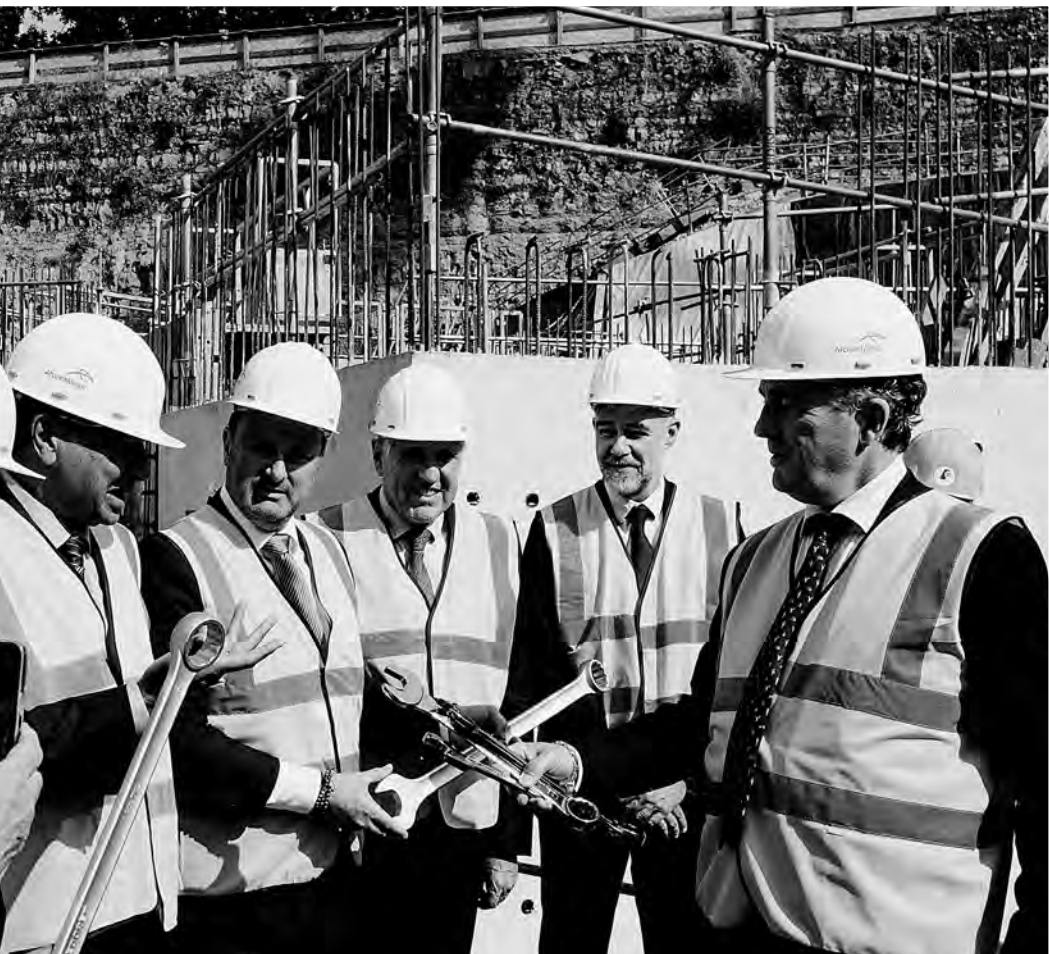
Le Luxembourg, une solution clé en main pour ArcelorMittal
