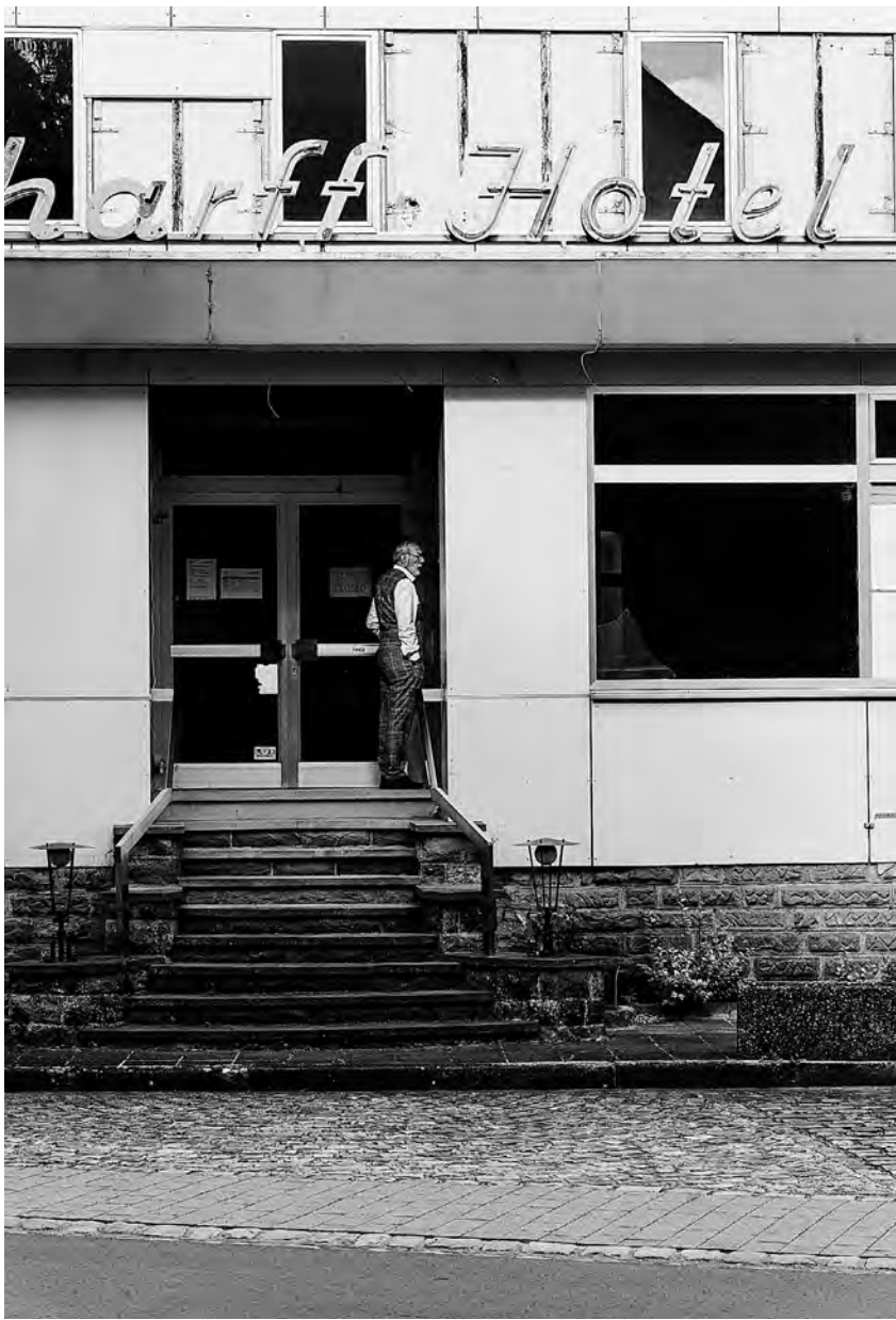
À Berdorf, l'hôtel Scharff n'est plus que l'ombre de lui-même
