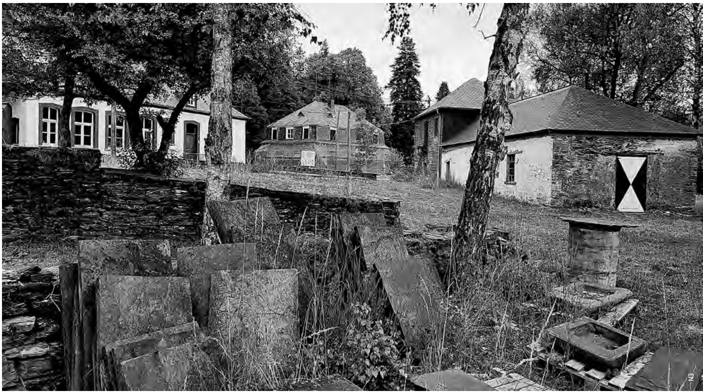
La Villa Rother est en cours de rénovation
