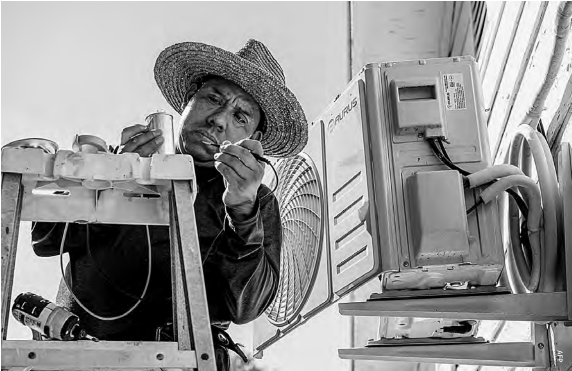
Technicien réparant une clim' au Texas
