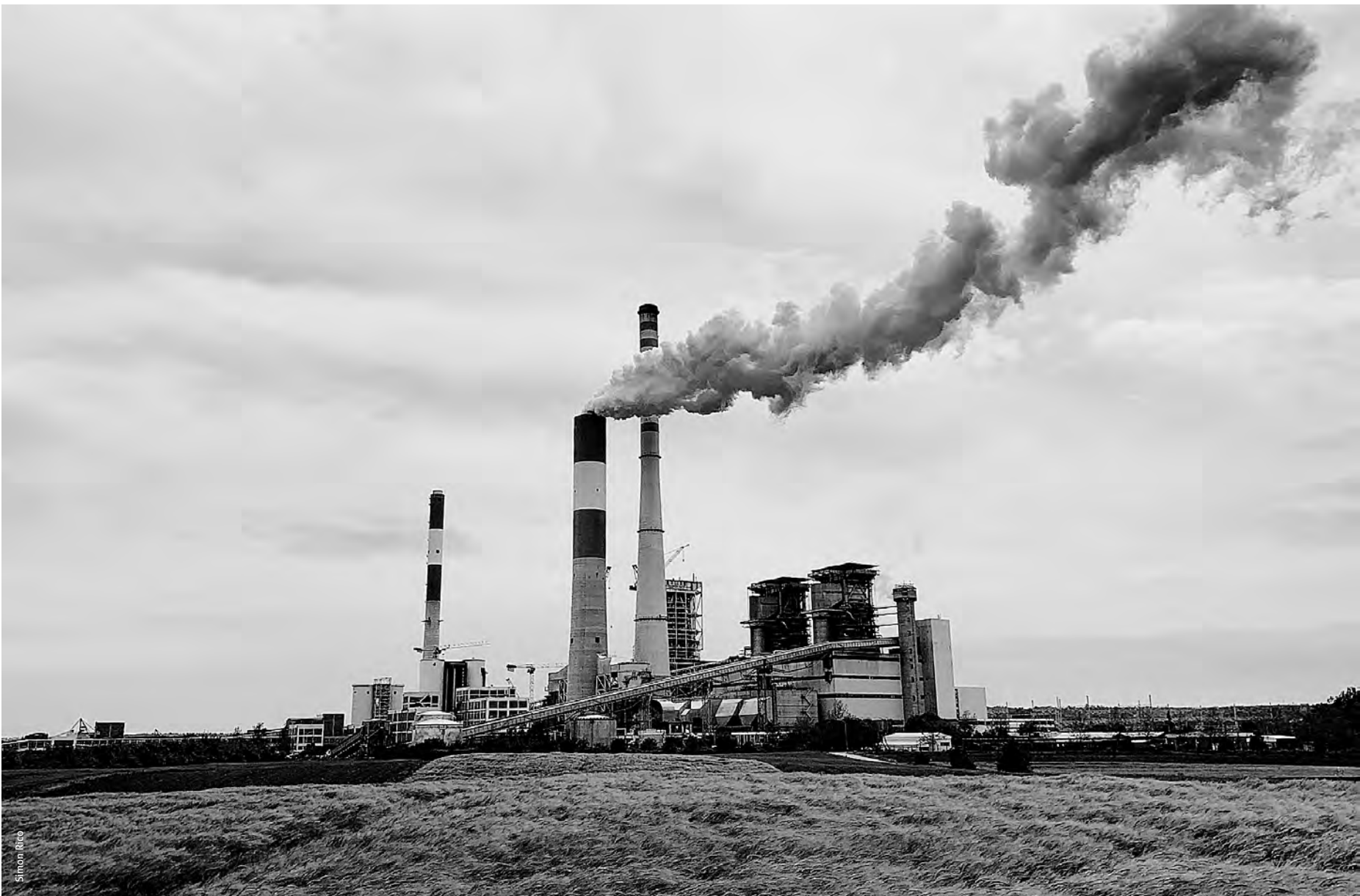
La centrale Kostolac B
