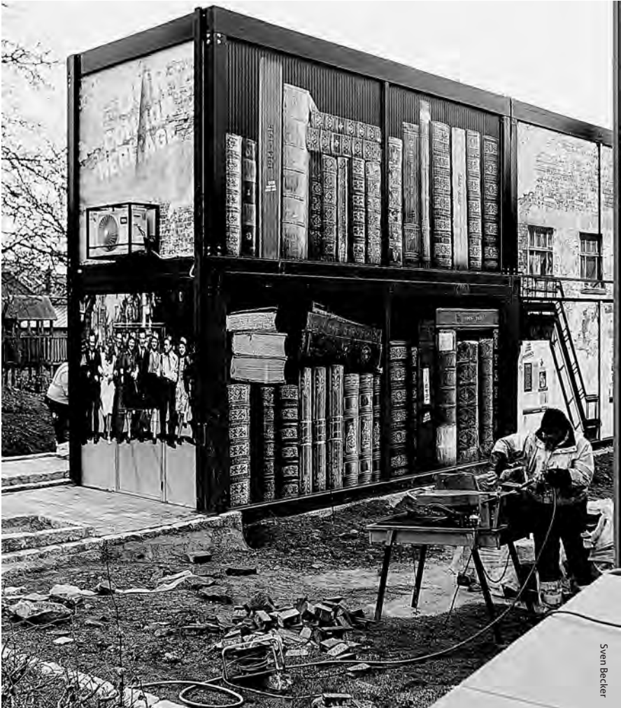
Arbeiten im März in Boulaide zum Aufbau eines
