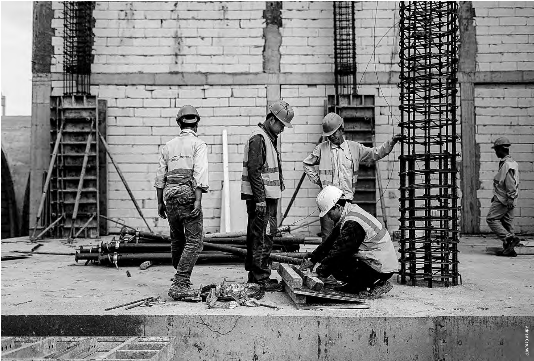
Des travailleurs vietnamiens sur un chantier à Bucarest en septembre 2019
