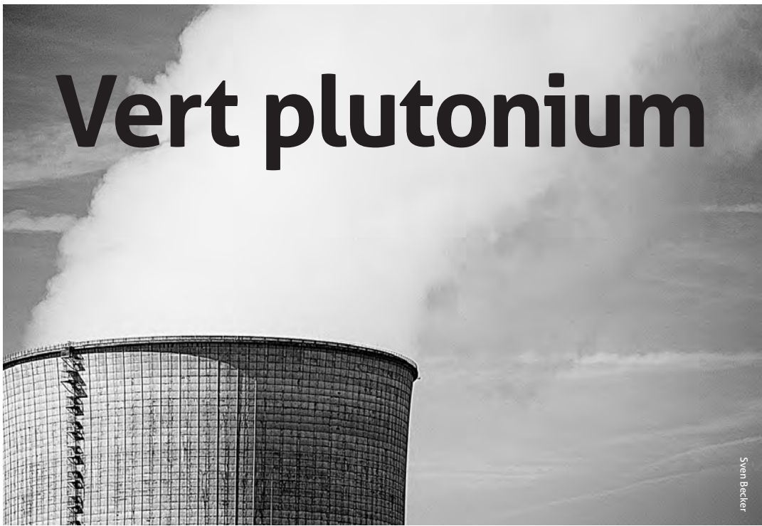
La centrale de Cattenom
