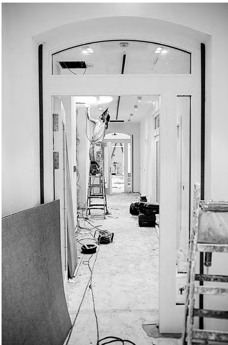
Les transformations du Bridderhaus conservent la structure des chambres de part et d'autre du couloir
