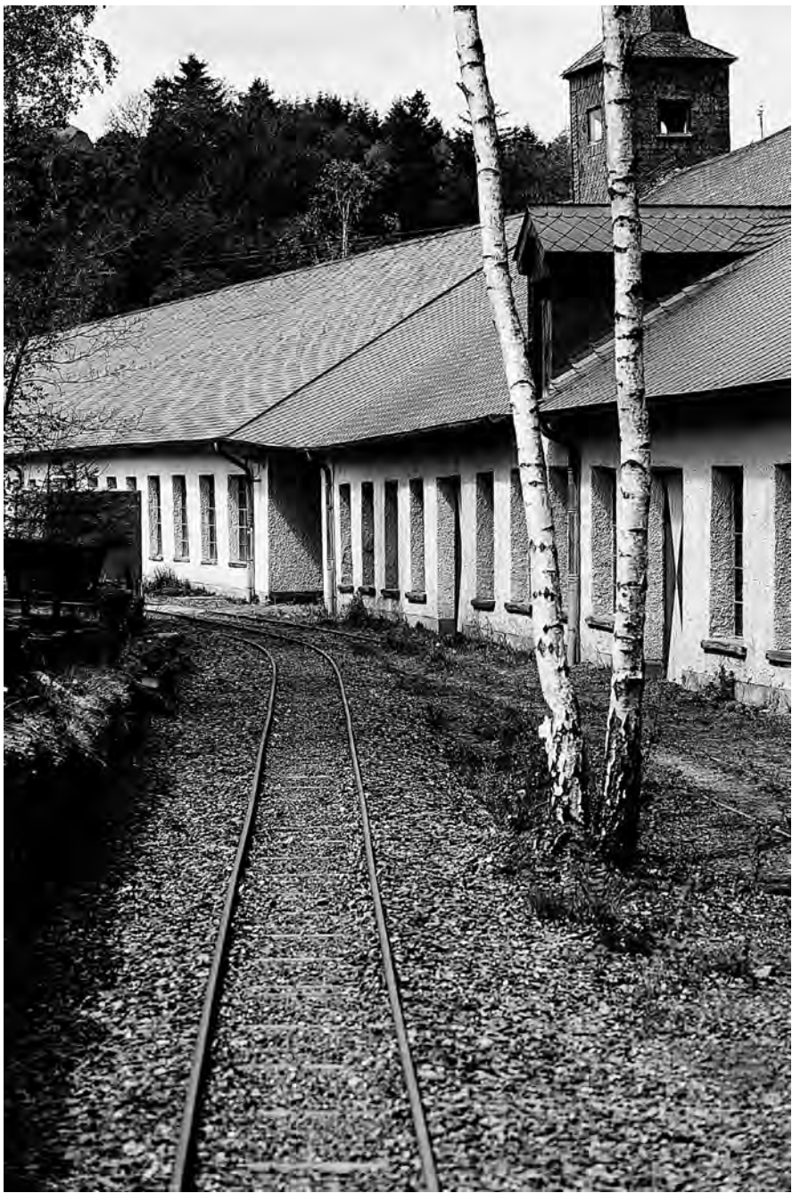
Le circuit ferroviaire a été remis en état pour attirer les touristes
