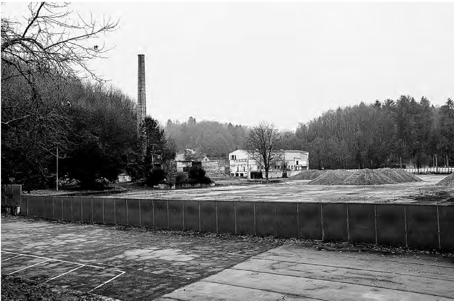
La cheminée, trace romantique du passé industriel du site, sera préservée
