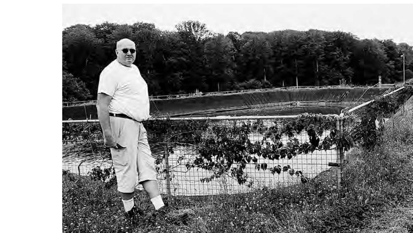
Claude Kirsch pose devant son bassin de rétention des eaux de pluie
