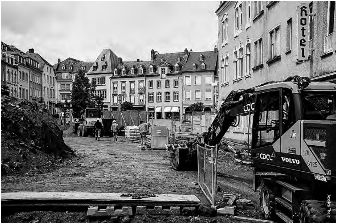
Vue actuelle sur la Place du marché depuis le chantier de la Petite Marquise
