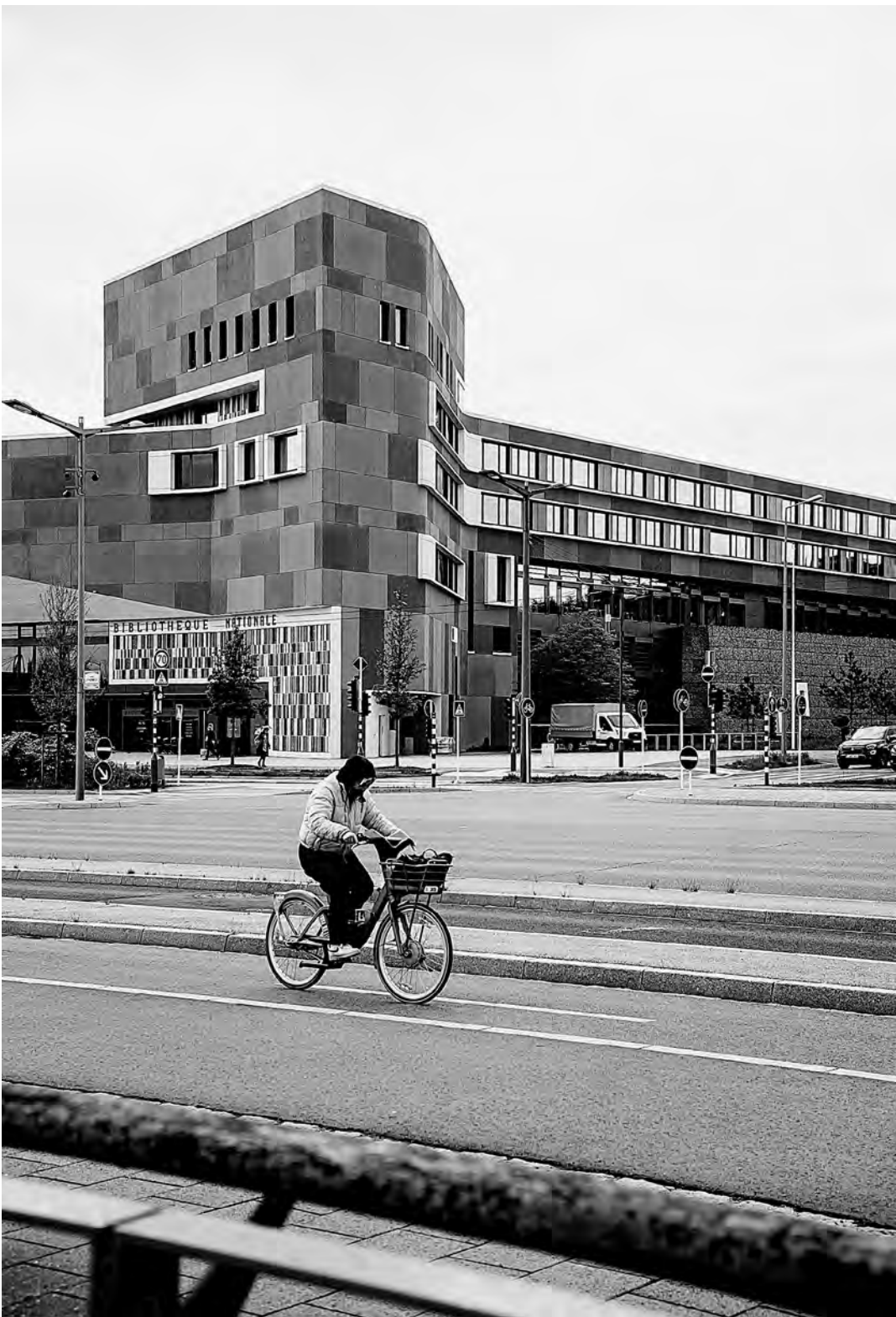
Le nouveau bâtiment au Kirchberg a été inauguré le 30 septembre 2019
