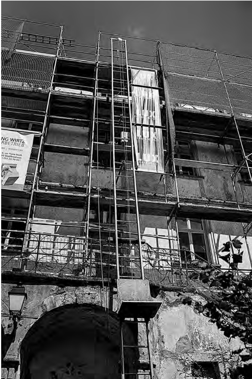
Travaux de rénovation à Larochette
