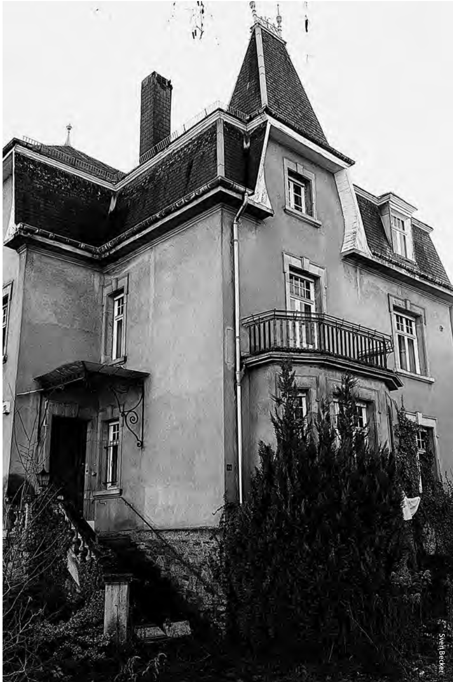
La Villa Marx, avenue du Dix Septembre, attend sa démolition
