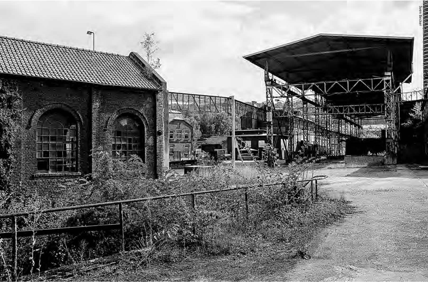
Le site d'ArcelorMittal à Dommeldange s'étale au nord de la ville où la vie peine déjà à trouver sa place entre les reliefs et l'Alzette
