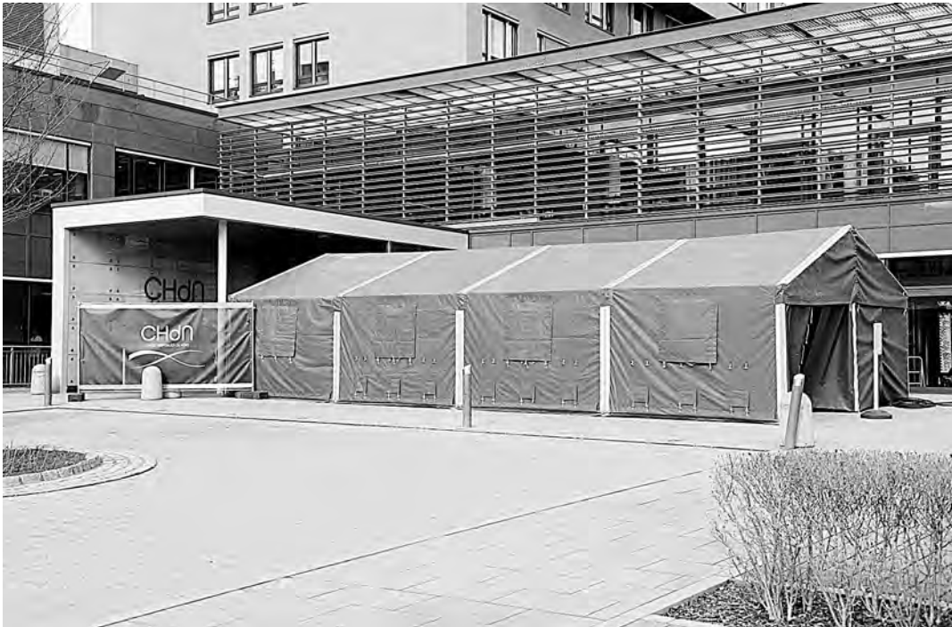
Das Zelt vor dem Eingang zum Ettelbrücker Krankenhaus war das erste, das die Armee in der Corona-Krise errichtete
