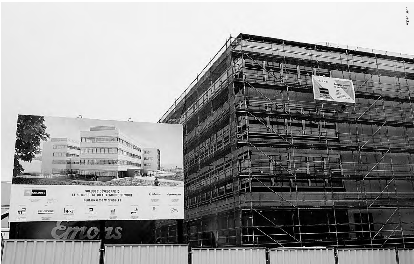
In der Rue des Bruyères in Howald entsteht der neue Sitz von Saint-Paul Luxembourg. Das Gebäude (Besitzer Lafayette und Soludec) soll 2021 fertig sein
