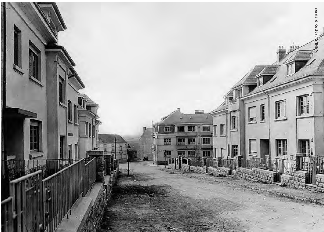
Maisons construites par la SNHBM entre 1933 et 1937, rue Bernard Haal (Belair)
