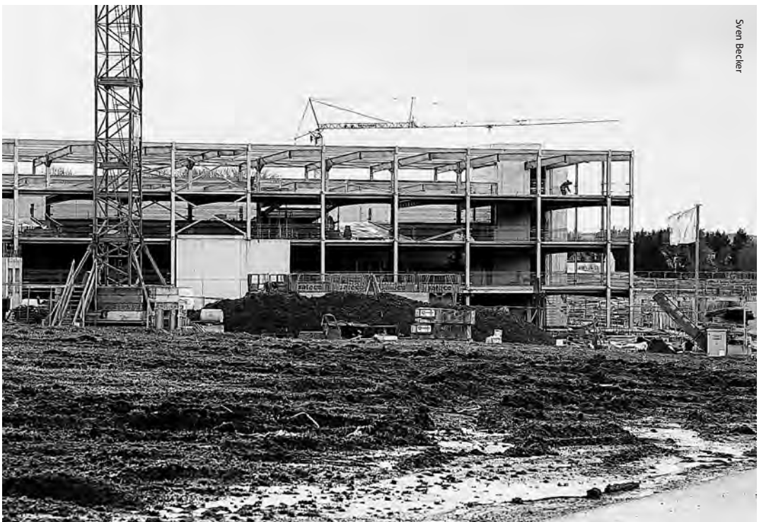
Chantier du projet Elmen (Capellen) qui prévoit à terme une population de 2 000 personnes
