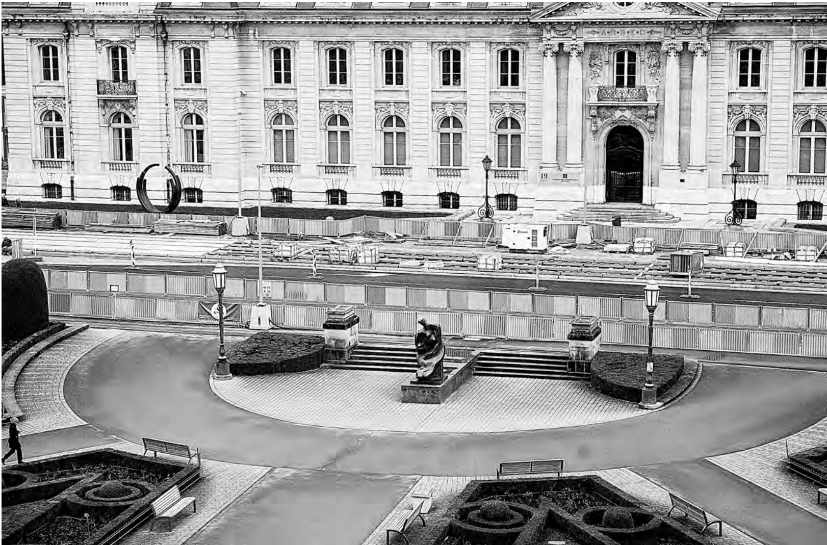
Vue sur le chantier du tramway, avenue de la Liberté, depuis le bureau de Dan Kersch
