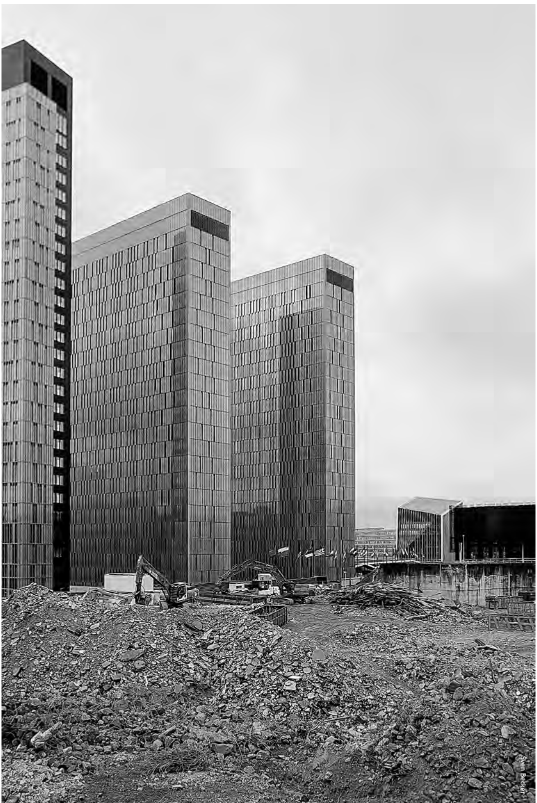
Le Jean Monnet 1, premier siège de la Commission européenne à Luxembourg, n'est plus qu'un cratère avec un tas de gravats devant la Cour de justice cette semaine. Le nouveau bâtiment, Jean Monnet 2, est en construction à quelques centaines de mètres de là
