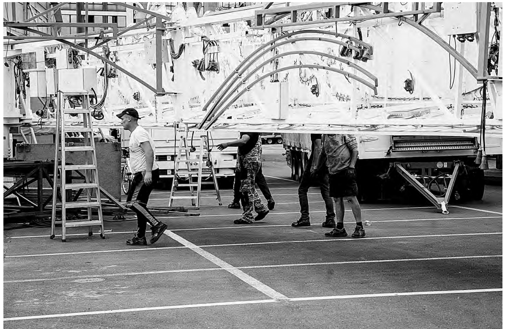
Die Schueberfouer im Aufbau
