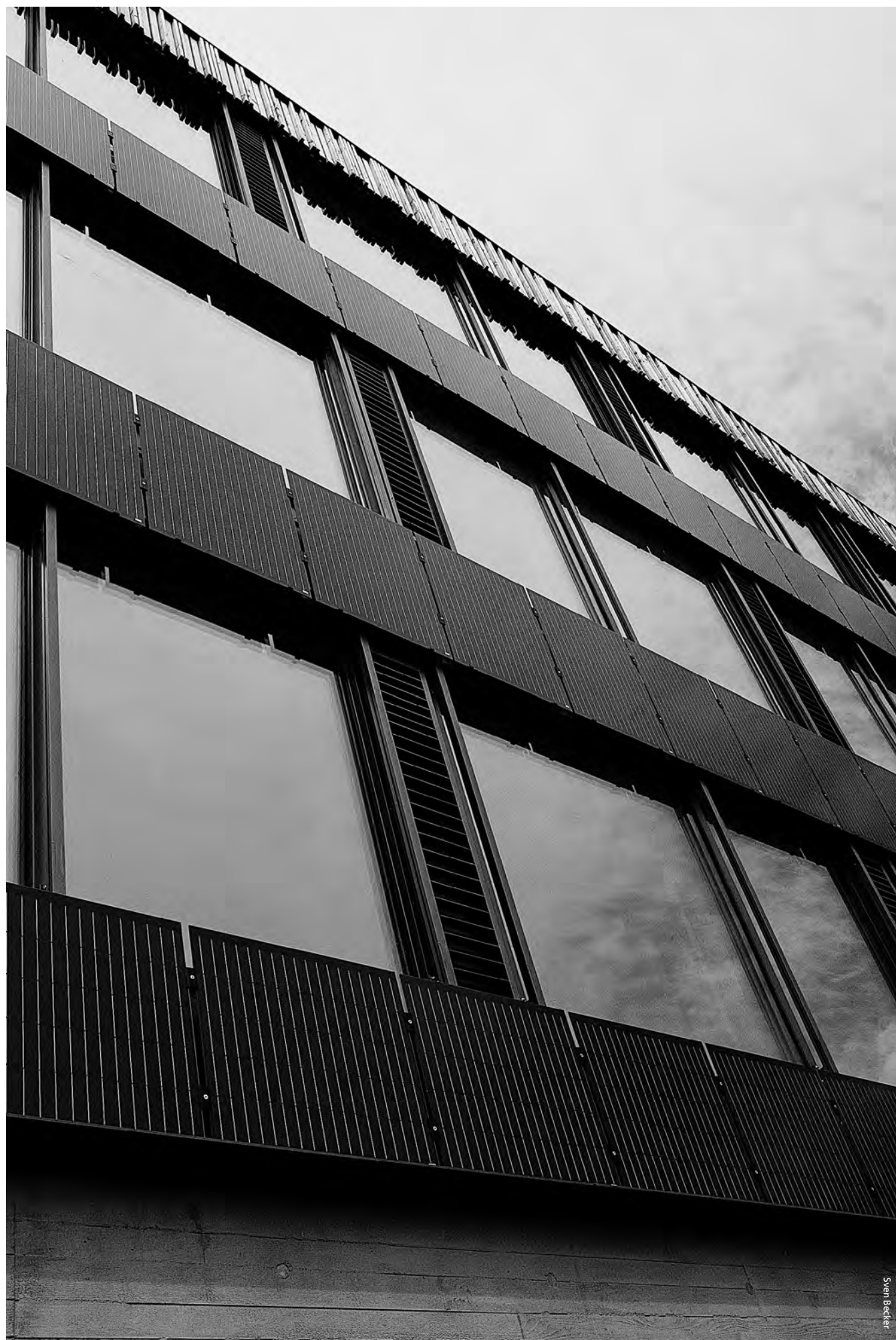
Büros hinter Photovoltaik-Fassade: Gebäude der staatlichen Naturschutz- und Forstverwaltung in Diekirch
